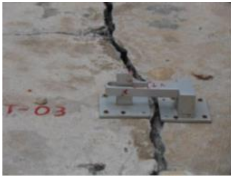
Figura 11. Grietas en la estructura del Baluarte de San Pedro
