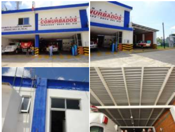
Figura 11 Estación de bomberos conurbados
