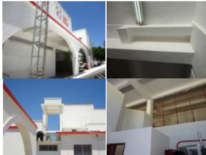
Figura 7 Sub estación de bomberos “DIF Lavaderos”
