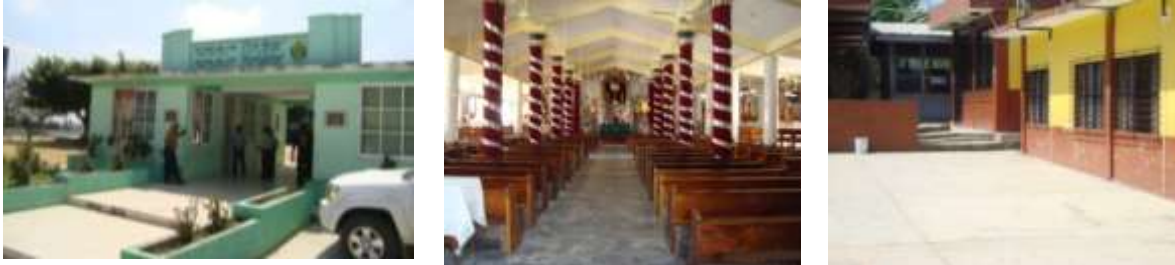
Figura 11.- Tipo de estructuras que presentaron daños.
