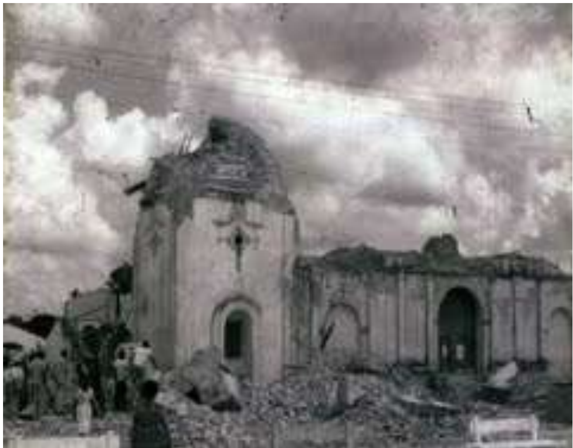
Fig. 2.2 La iglesia de Jáltipan destruida por el sismo
