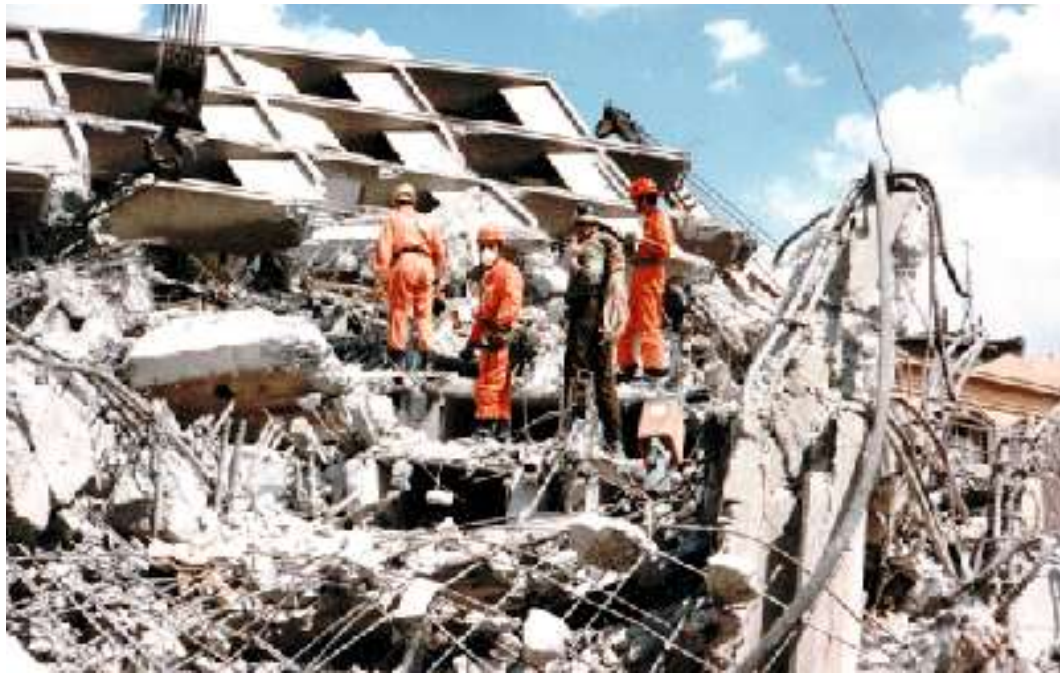
Fig. 2.1 Edificio de la ciudad de México destruido en el sismo de 1985
