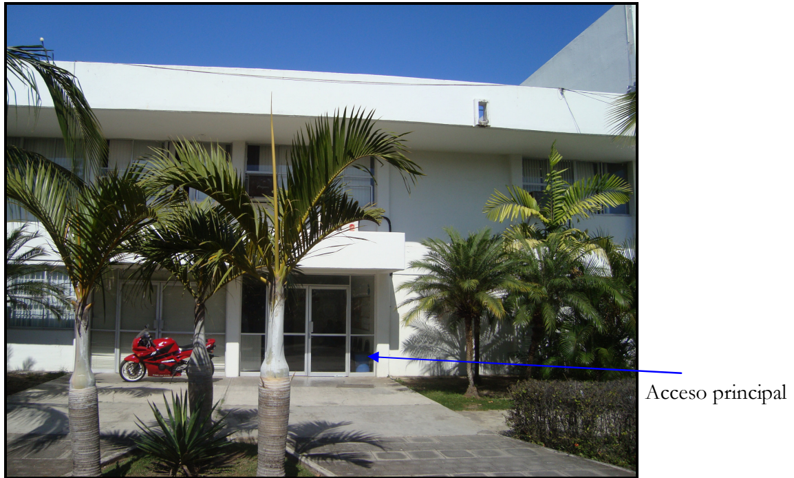
Figura 5.1.1 - Fachada edificio Instituto de Ingeniería.
