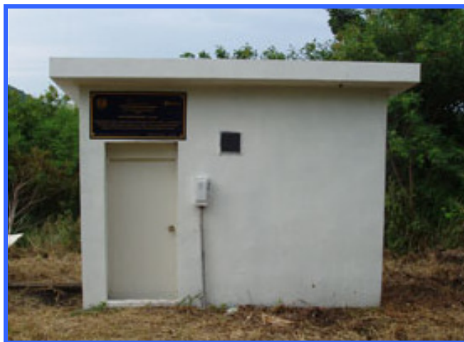
Fig. 3.5.- Estación de Red de Banda Ancha.
