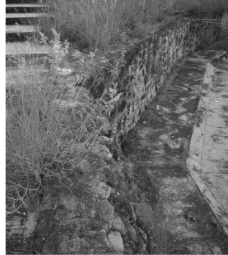
Fig. 2.11 Muro de retención
