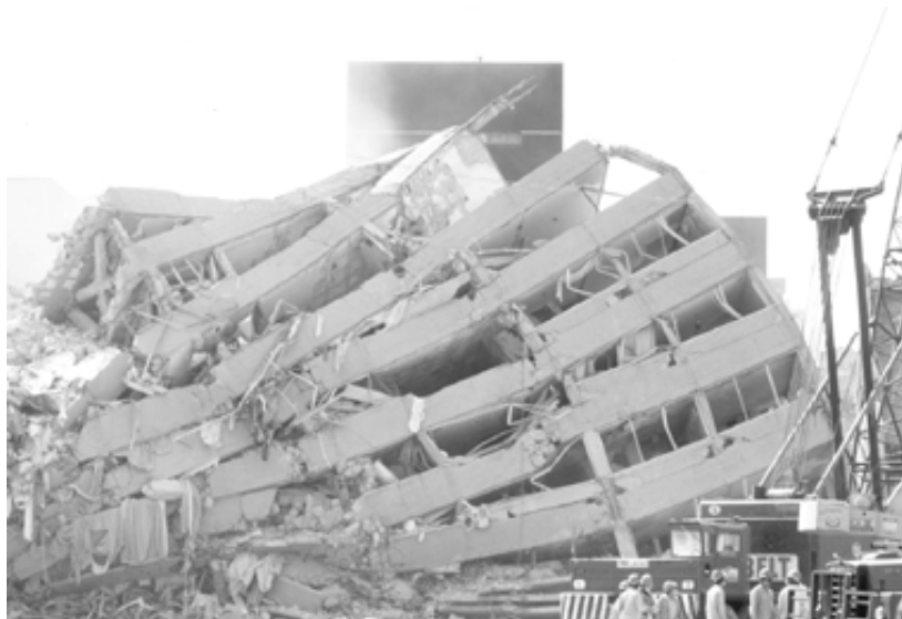
Fig. 2.1.- Falla de un edificio en el sismo de 1985 en la Cd. de México.
