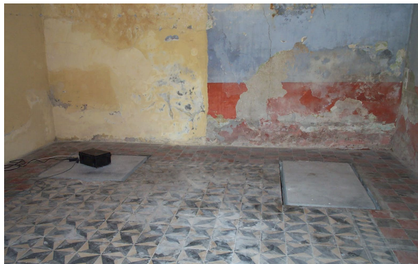
Figura 2. Bases de los antiguos sismógrafos
